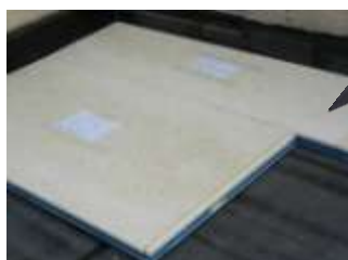
Verlegung laut Verlegeplan
