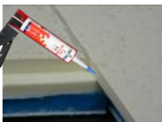
Verklebung mit PUR-Kleber
