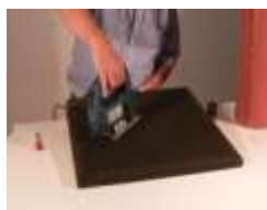
Schneiden mittels Messer oder Stichsäge
