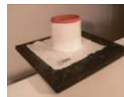
Einsetzen d. Rohres
