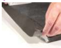
Schrägschnitt und Abkleben der Schnittstelle
